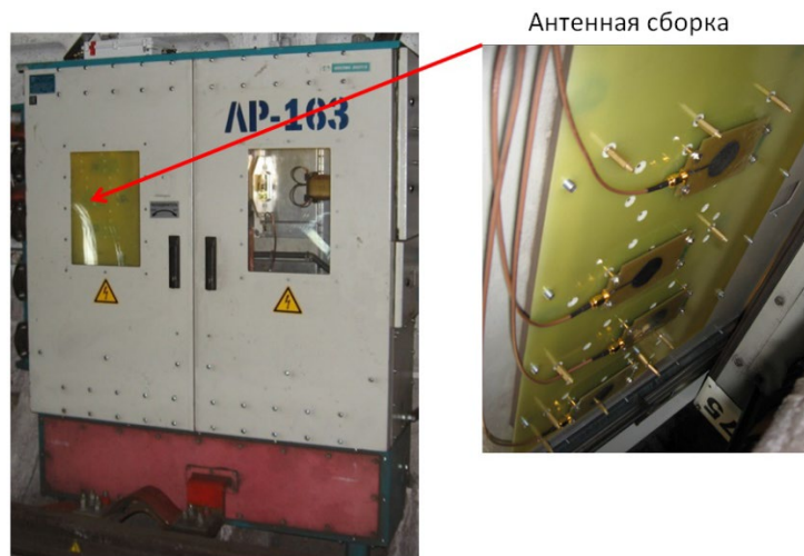
Рисунок 3. Шкаф ЛР-163 в закрытом состоянии и антенная сборка системы ПАВ-Термо-В.
